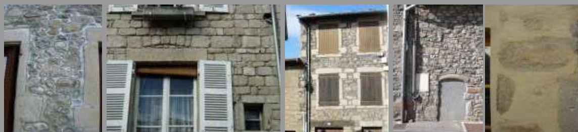
Joints rubanés, joints tirés au fer, joints ciment, joints en creux et joints beurrés : tous ces exemples sont à interdire
