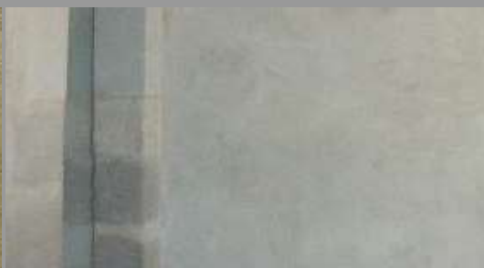
Enduit plein au mortier de chaux teinté dans la masse, finition lissée.
