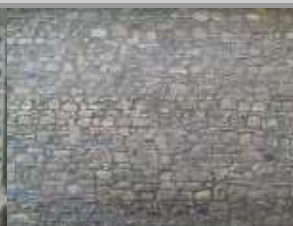
Le mortier au ciment et les joints en retrait sont interdits
