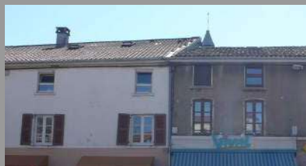
Les ouvertures des combles sur la façade de gauche sont suffisamment décalées par rapport à la toiture, celles de droite ne le sont pas.
