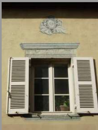
Enduit plein au mortier de chaux teinté dans la masse, finition grattée à la truelle.
