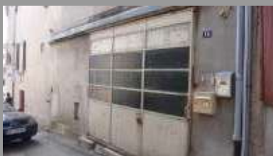
Porte métallique sur rail extérieur à proscrire
