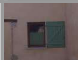
A droite : Les volets Z et volet à un seul battant (pour une dimension supérieure à 40 cm de large) sont proscrits.
