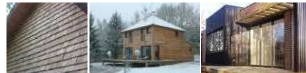
Exemple de bardages bois et métal
