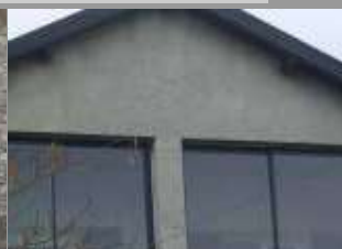
Les enduits projetés à la machine sont interdits
