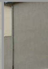
Enduit plein au mortier de chaux teinté dans la masse, finition lissée et passe de badigeon au lait de chaux.
