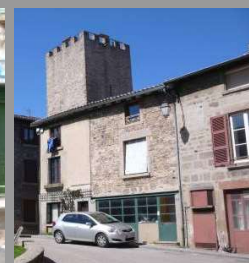
Rez-de-chaussée remaniés et remaniable
