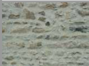
Joint plein au mortier de chaux et sable de rivière à reproduire
