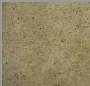
Enduit plein au mortier de chaux teinté dans la masse, finition grattée à la truelle.
