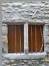
Fenêtre à meneau et arcs de décharge en bois
