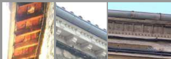
Dépassée de toiture traditionnelle: voligeage et chevrons
