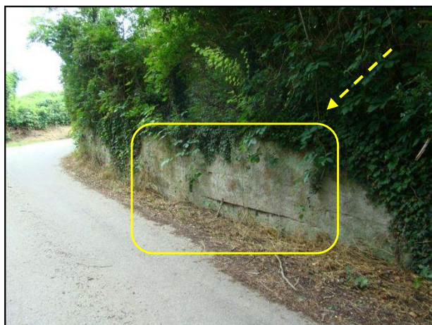
Figure 19 : Mur de soutènement très fissuré (du fait de la poussée des terrains) en bas du chemin des Bines
