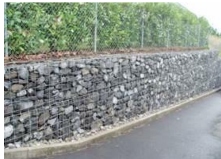
Muret en gabion autorisés
