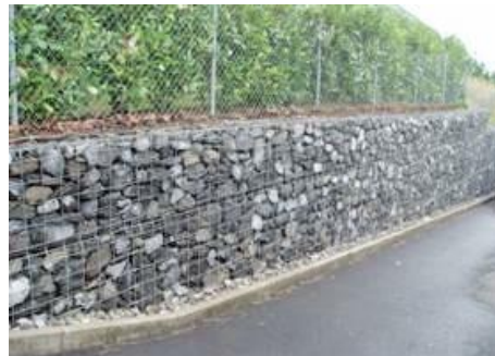
Muret en gabion
