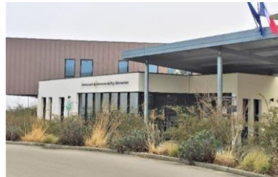
Locaux de la COPAMO (secteur Grange Dodieu)
